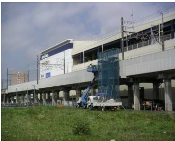
鉄道高欄改修の例
