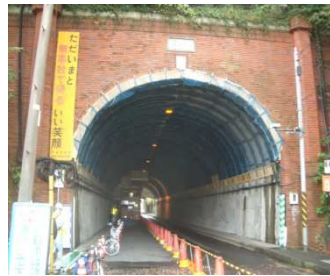
道路トンネル改修の例
