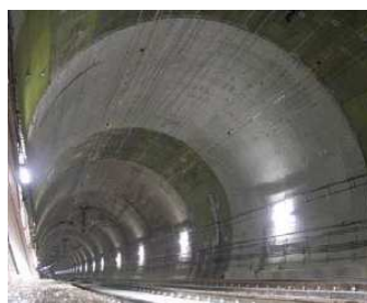
鉄道トンネル改修の例
