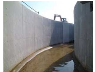
農業用水路壁面改修の例
