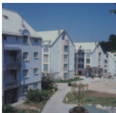
ビニロンを使用した屋根と壁
